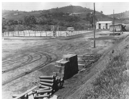
Obras de construção do Centro Recreativo de Cláudio
